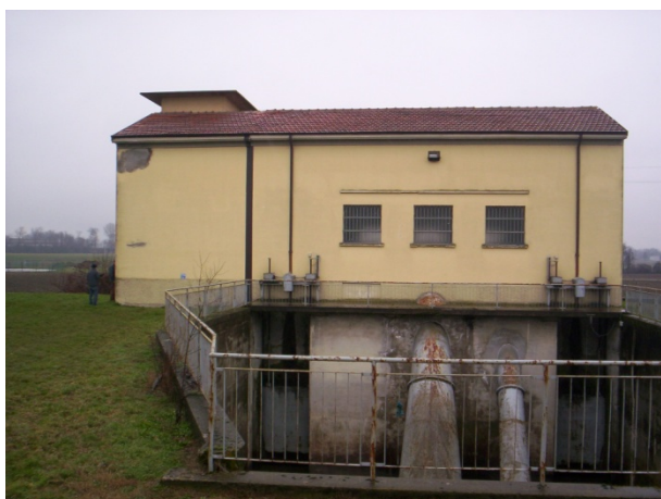
Figura 146 – Impianto idrovoro 'Tencara'.
