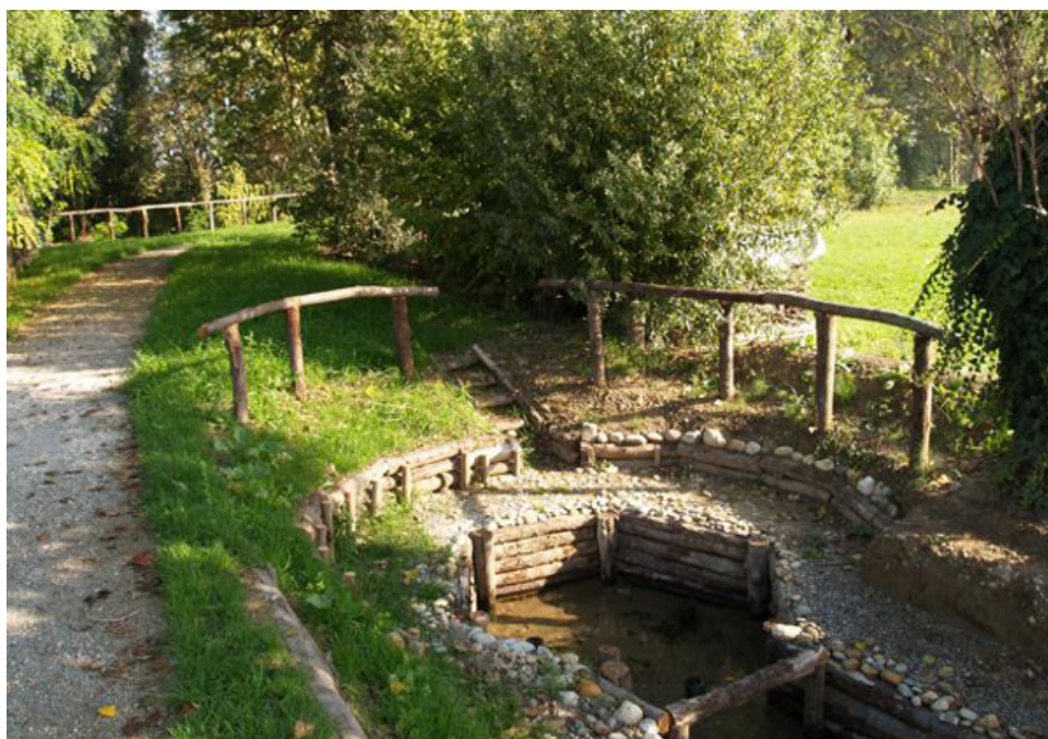
Figura 162 – Testa di fontanile ristrutturata.
