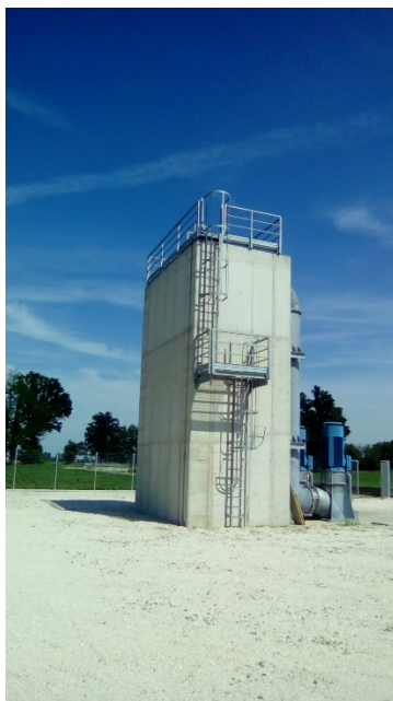
Figura 45 - Pozzetto imbocco Diramatore Pieve San Giacomo.
