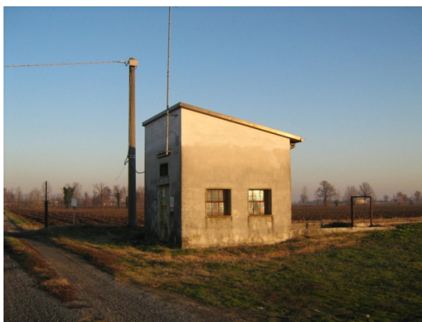
Figura 149 – Impianto irriguo Bissolina.
