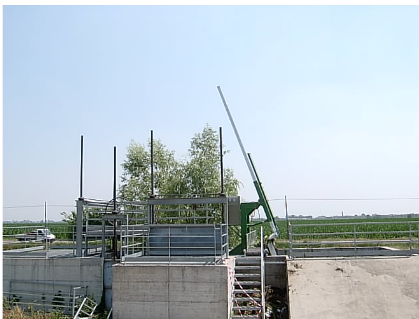
Figura 55 - Pozzetto imbocco diramatore Torre e Isola al termine del Nuovo Bolla.
