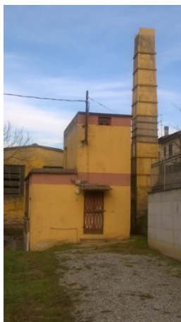
Figura 152 – Impianto irriguo Cavatigozzi.
