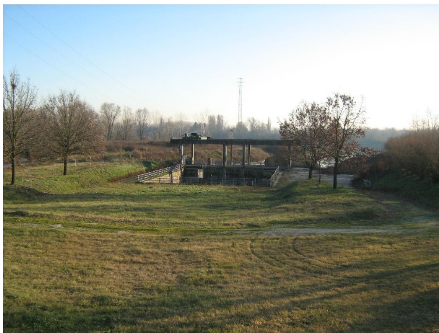
Figura 47 - Impianto presollevario Isola Pescaroli (Consorzio Navarolo).
