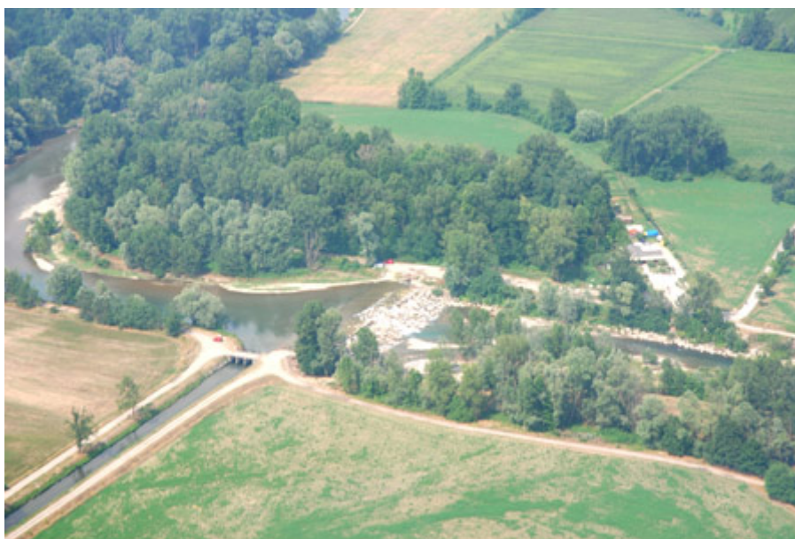
Figura 72 - Opera di presa Cavo di Suppeditazione.
