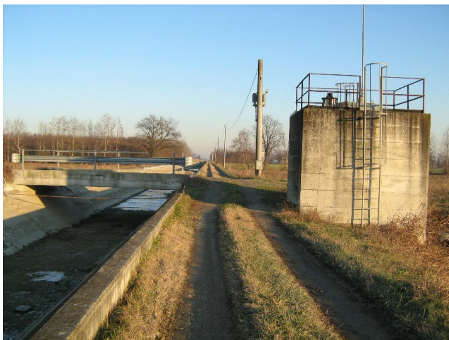
Figura 46 - Manufatto di imbocco Diramatore di Sospiro dal CPFM.
