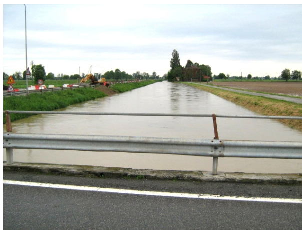
Figura 148 - Alluvione 2010: stato di criticità nel bacino Dugale - Tagliata.
