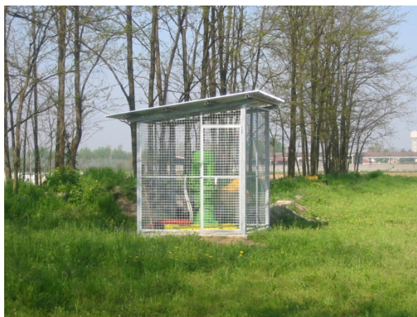
Figura 151 – Impianto irriguo Pozzo Paderno.
