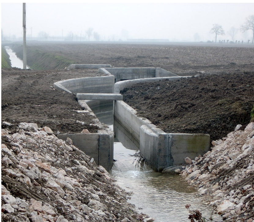
Figura 34 - Manufatto di scarico dal cavo Magio in Scaricatore Piadena (in sx nella foto).
