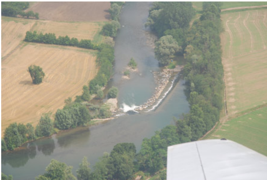
Figura 69 – Opera di presa del cavo Calciana dal fiume Oglio.
