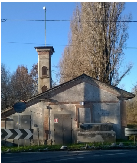
Figura 142 – Impianto idrovro 'Binanuova'.
